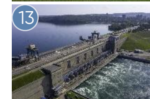
Плотина Иркутской ГЭС (47 км, 50 мин)
